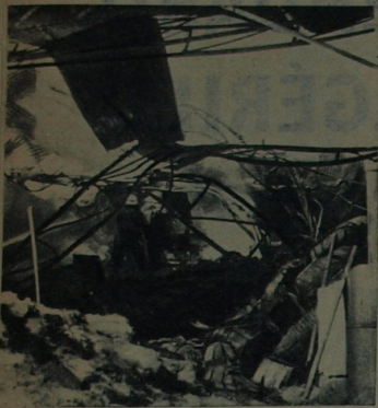
BOUFARIK : LA COOPERATIVE DETRUITE.
